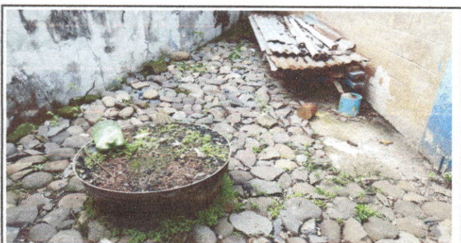
Foto 6: Estado actual de piso en área de cocina
