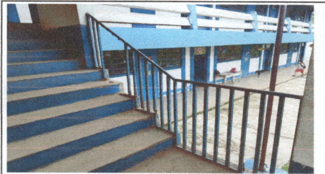
Foto 4: Situación actual de barandas en módulo de gradas
